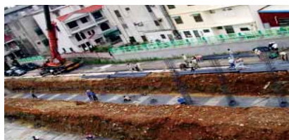
興建中的第二期教室工程
