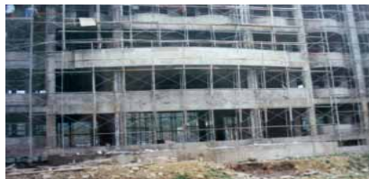
興建中的第一期教室工程
