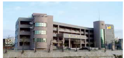
第一期教室工程完工照
